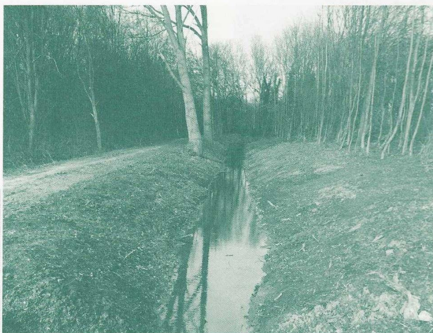
De herstelde gracht van de Hateboer. De binnengracht op de voorgrond is al gedeeltelijk gevuld met water. Links van het pad loopt de nog droge buitengracht.
