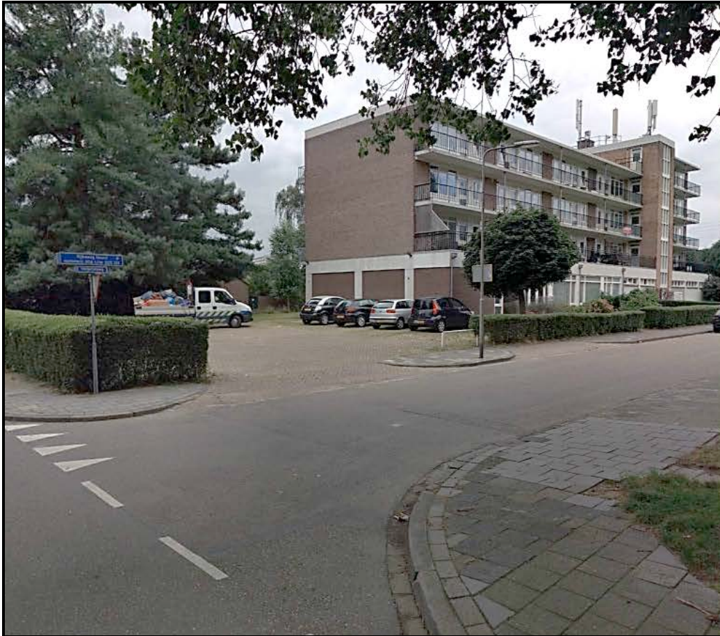
Figuur 3: Bestaande appartementengebouw en parkeerplaats aan Heijersteeg, hoek Rijksweg-Noord
