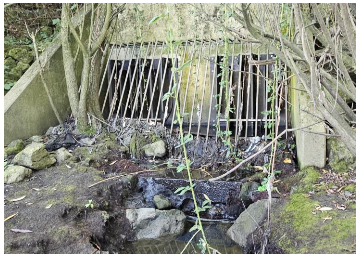
Figuur 1, overstort bij Venlo direct op de Maas, duidelijk is ook de grote hoeveelheid sanitaire doekjes te zien.
